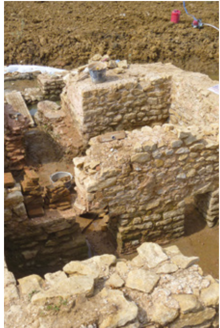
Les thermes en cours de restauration
