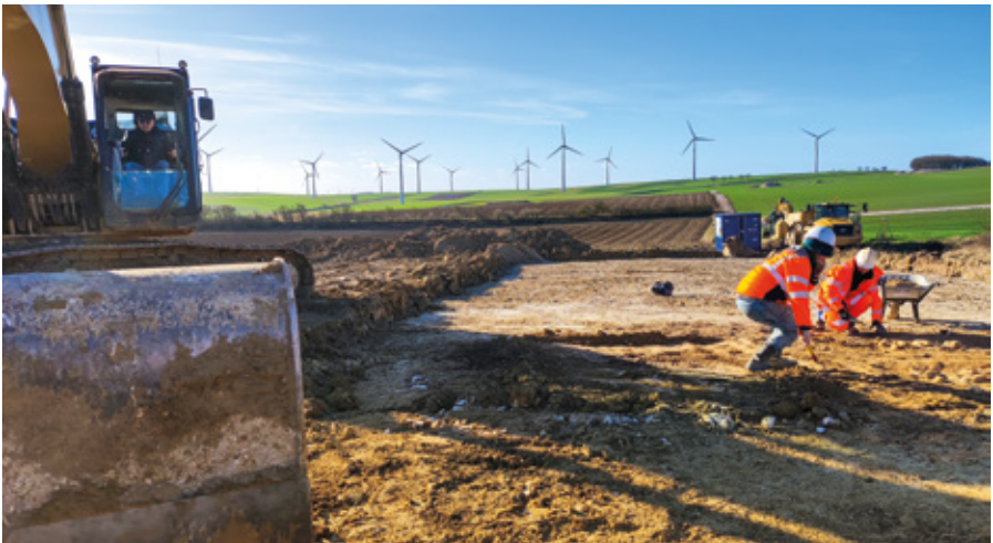
Fouille en cours à Écly
